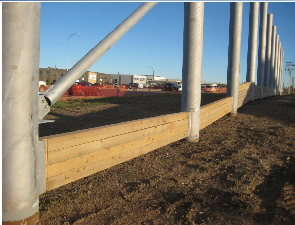
Перемычки вписаны в структуру ветрового барьера
