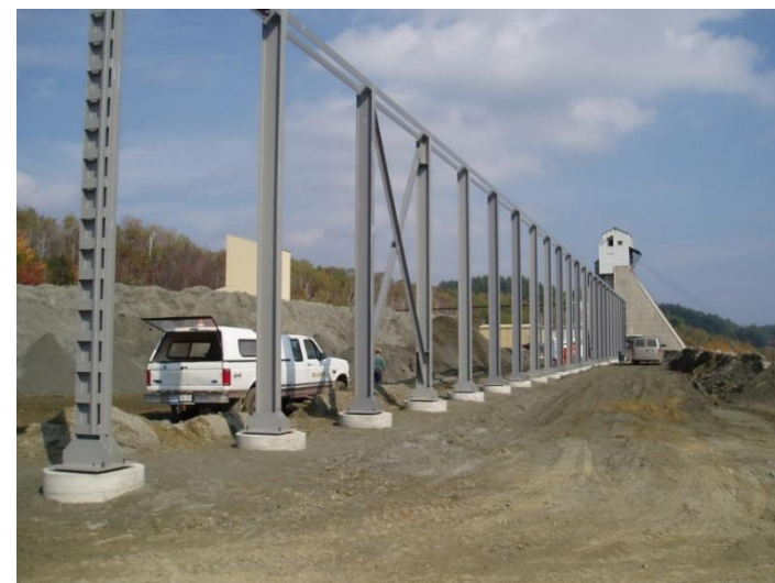
Двутавровые балки на фундаменте
