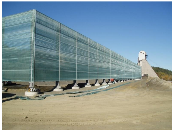
Двутавровые балки на фундаменте
