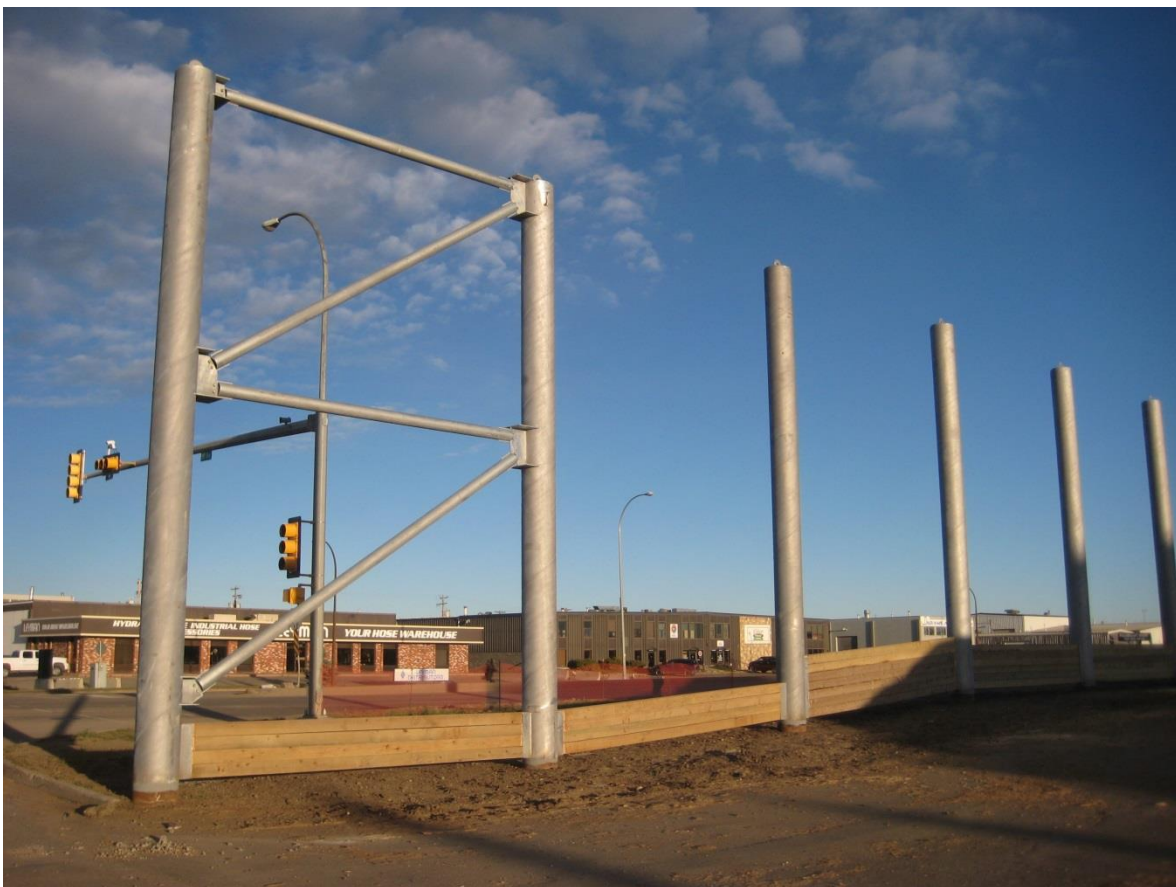
24 дюймовая труба забита в землю и затем обрезана на уровне земли. Новая труба наварена на основание .
